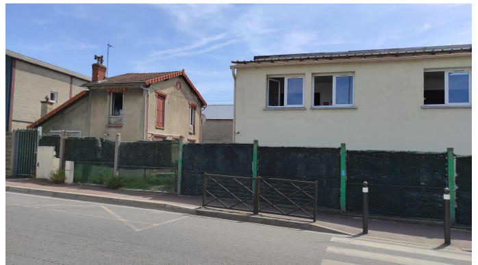
Ecole et logements rue de Montigny
