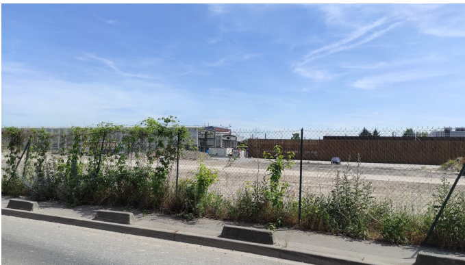
Vue vers le technicentre situé au sud
